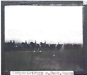
Glasdia vor der Restaurierung
